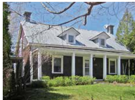
Maison recouverte de bardeau de bois avec une toiture en tôle à baguettes
