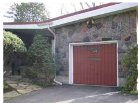
Porte de garage en bois dotée de petites ouvertures
