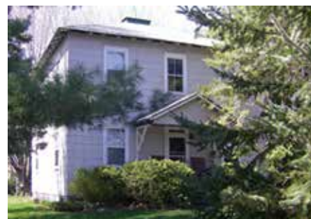
Maison cubique recouverte de tuiles d'amiante-ciment
