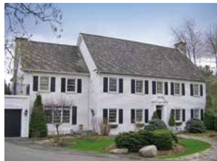
Grand cottage de deux étages et demi de style néogéorgien dont les murs sont en planches de bois à clins et la toiture, en bardeau de bois
