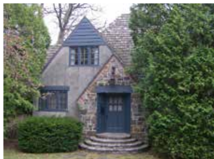
Maison revêtue de pierre et de crépi avec une toiture en bardeau de cèdre
