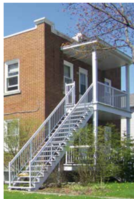
Duplex muni de galeries superposées et d'un escalier dont les garde-corps sont uniformisés
