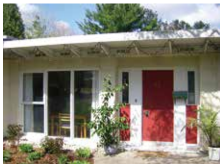
Grande fenêtre et porte opaque rouge dotée de baies latérales sur un bungalow d'après-guerre
