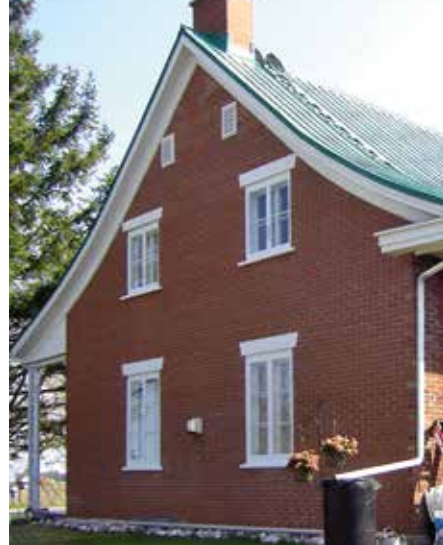
Fenêtres à battants en bois à six et à quatre grands carreaux
