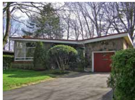
Bungalow revêtu de pierre naturelle et couronné d'un toit à pente inversée en « V »
