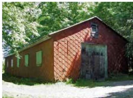
Entrepôt de pommes dont les murs sont recouverts de tuiles d'amiante-ciment
