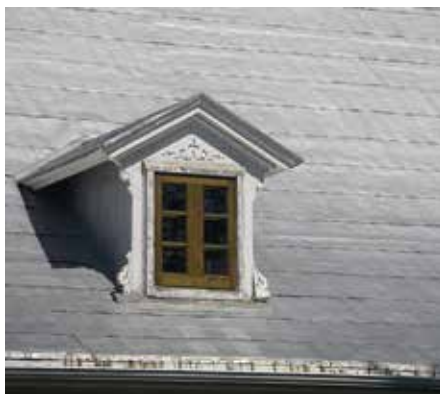
Maison franco-québécoise avec toiture en tôle traditionnelle
