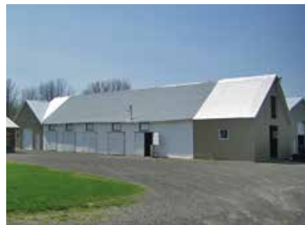
Ces bâtiments de ferme connaissent une seconde vie grâce à l'exploitation d'un vignoble.
