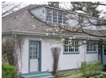
Portes et fenêtres en bois munies de petits carreaux
