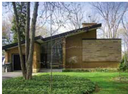
Bungalow avec des murs recouverts de brique et de pierre artificielle et avec un toit à un seul versant
