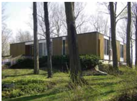
Maison moderne au volume compact comportant peu de saillies
