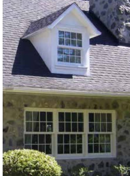
Fenêtres à guillotine à petits carreaux qui respectent le style de la maison
