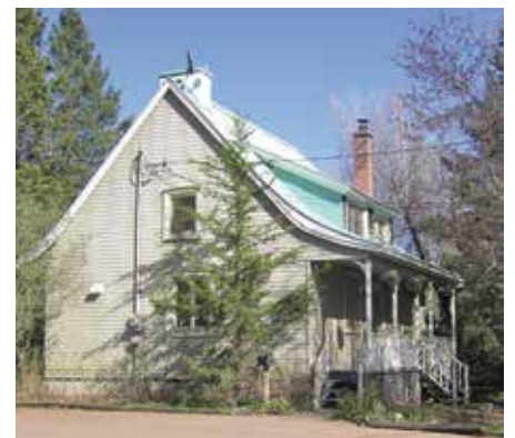
Bien qu'elle soit revêtue de bois, cette maison franco-québécoise est reconnaissable à sa toiture à la pente très prononcée.
