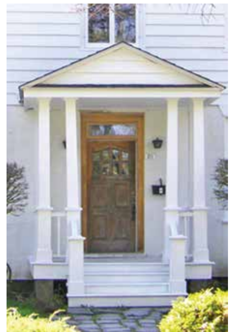
Porche aménagé devant une entrée principale
