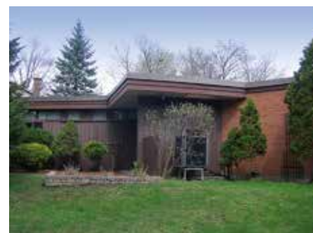
Façade anguleuse d'un bungalow
