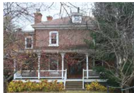
Maison cubique recouverte de brique
