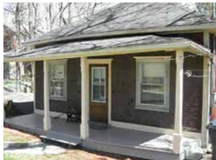
Porte en bois et fenêtres à guillotine
