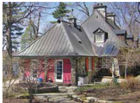
Maison en pierre coiffée d'une toiture à croupes en cuivre
