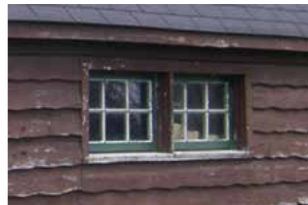
Fenêtres en bois à carreaux sur un garage
