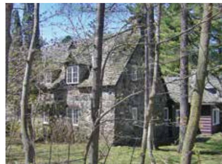
Maison en pierre avec une toiture recouverte de bardeau de cèdre
