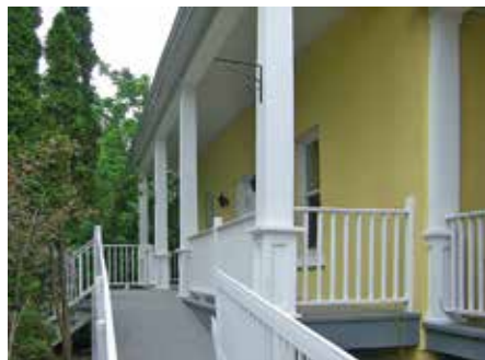
Les garde-corps et autres composantes des galeries sont préférablement en bois de facture traditionnelle.
