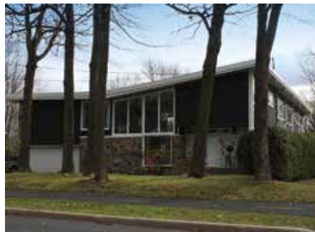
Façade percée de grandes fenêtres en mur-rideau et entrée en alcôve à droite
