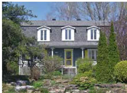
Maison à mansarde recouverte de planches de bois à clins
