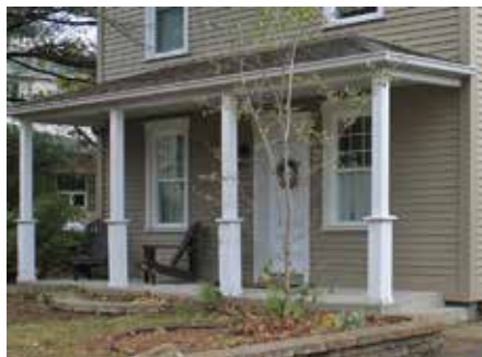
Galerie couverte en façade d'une maison Boomtown
