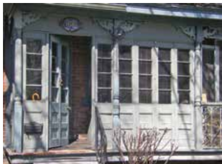
Cette galerie a été transformée en véranda fermée par une porte et des fenêtres en bois.
