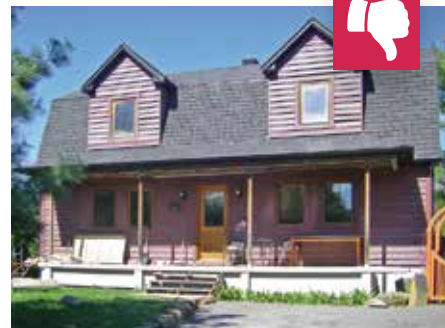
Les lucarnes ajoutées sur cette maison à mansarde sont disproportionnées et affectent l'architecture.
