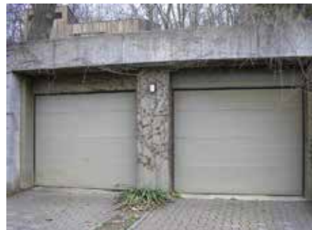
Portes de garage dans un mur de béton
