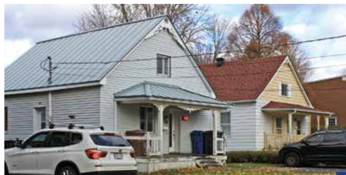
La galerie couverte en façade avant est un élément essentiel de ce modèle architectural.
