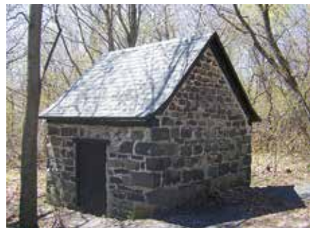
Ancienne laiterie en pierre dotée d'une toiture à deux versants à base recourbée
