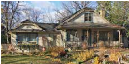
Cette maison d'influence Arts and Crafts a été agrandie sur le côté par l'ajout d'un volume reprenant plusieurs caractéristiques architecturales, dont la forme du toit.
