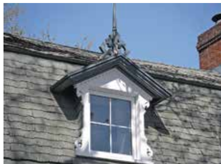
Lucarne à pignon dotée de boiseries décoratives
