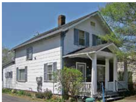
Cottage vernaculaire américain avec pignon en façade doté d'un parement en amiante-ciment et d'une toiture en bardeau d'asphalte
