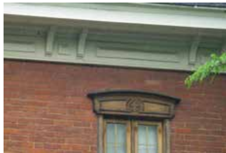
Corniche à consoles à la base du toit et boiserie décorative au-dessus d'une fenêtre
