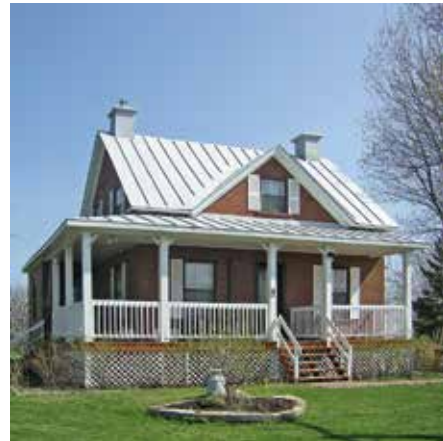
Cottage vernaculaire américain en brique avec toiture en tôle pincée
