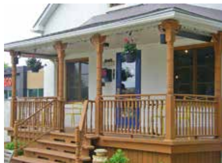
Galerie couverte et parée de plusieurs ornements sur la façade d'un cottage vernaculaire américain
