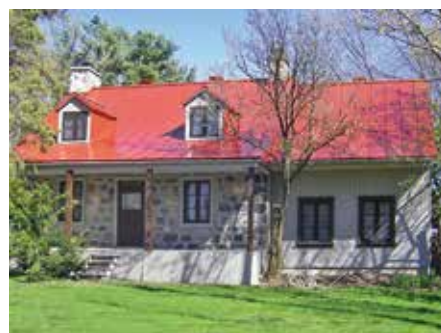
Maison traditionnelle québécoise en pierre avec toiture en tôle pincée
