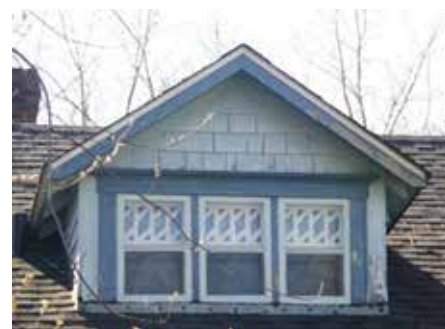
Lucarne à pignon recouverte de bardeau de cèdre
