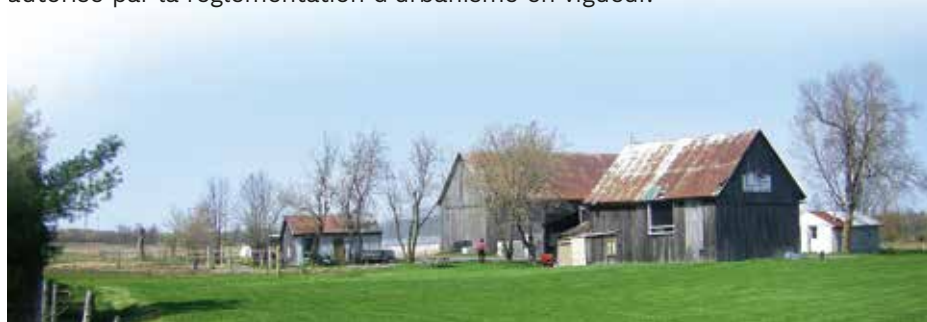
En milieu agricole, les nombreux bâtiments secondaires font partie du paysage et méritent d'être préservés.
