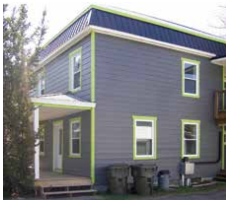
Ce revêtement de couleur foncée, avec des chambranles et des planches cornières de couleur contrastante, convient bien pour une maison Boomtown.
