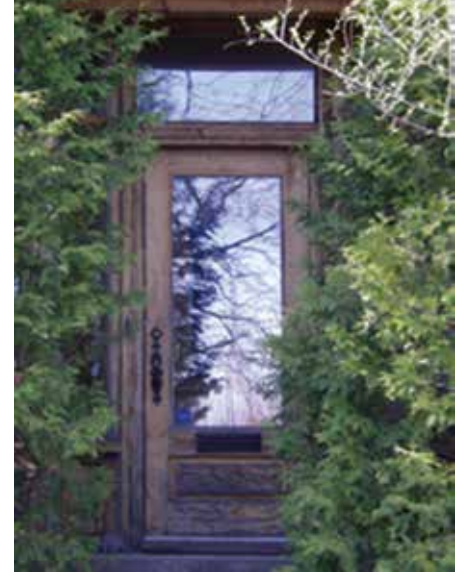
Porte en bois avec vitrage et imposte
