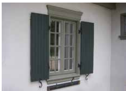
Fenêtre à battants en bois à petits carreaux
