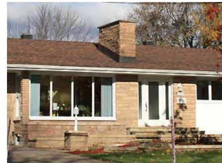
L'imposante cheminée est souvent la seule composante verticale du bungalow.
