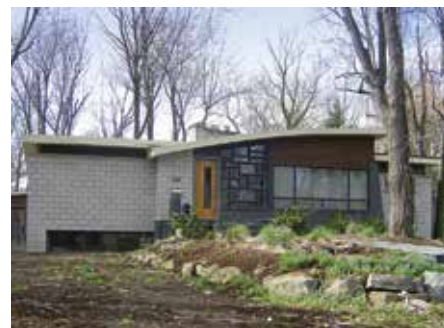
Porte d'entrée et très grandes ouvertures sur la façade de ce bungalow
