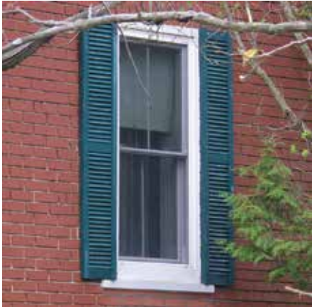
Fenêtre à guillotine : le meilleur modèle pour les cottages vernaculaires américains
