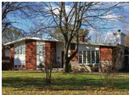
Bungalow revêtu de brique et de pierre, surmonté d'un toit à deux versants asymétriques
