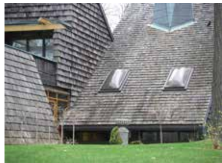
Maison Doris-Lussier, dessinée en 1964 par le célèbre architecte Roger D'Astous, entièrement revêtue de bardeau de cèdre
