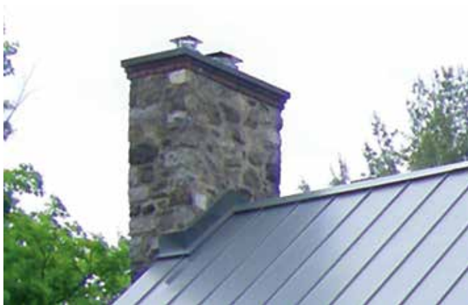
Cheminée en pierre se trouvant à l'extrémité d'une toiture
