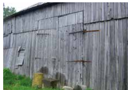
Porte à battants en bois sur une grange-étable
