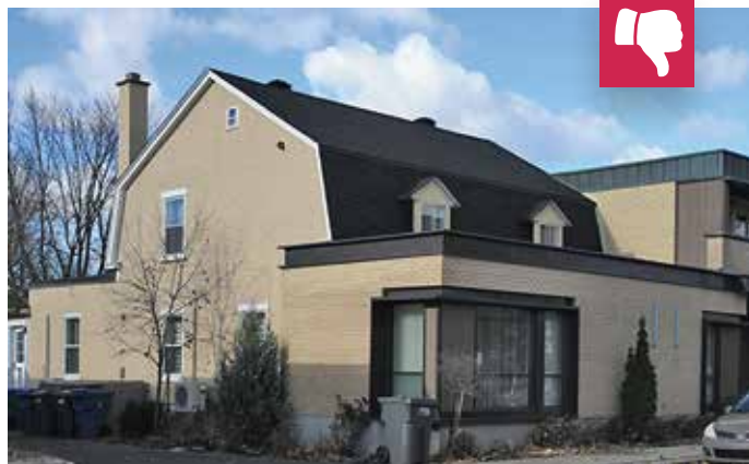
L'agrandissement du bâtiment par l'avant est une intervention irréversible qui affecte grandement l'intérêt patrimonial de cette maison.
