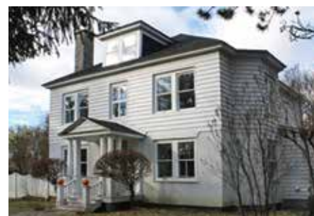
Maison cubique revêtue de crépi et de planches de bois à clins
