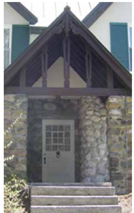
Porche d'entrée en pierre et en bois
