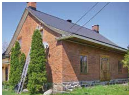
Maison en brique avec toiture en tôle profilée
