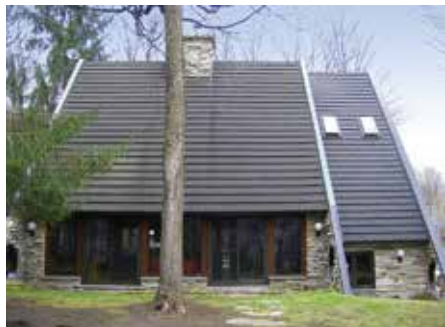
Portes et fenêtres occupant tout le mur du rez-de-chaussée
