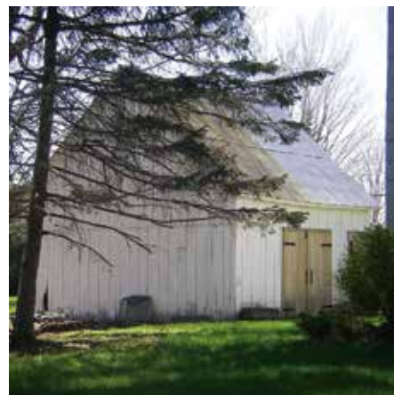
Hangar revêtu de planches de bois verticales peintes en blanc avec une toiture en tôle industrielle
