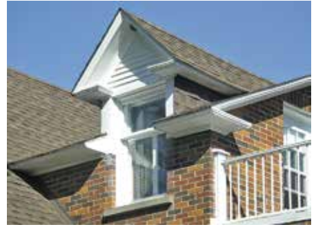
Lucarne à pignon à moitié engagée dans le mur, appelée lucarne pendante
