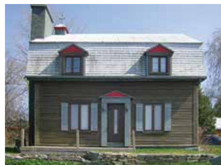
Maison à mansarde revêtue de bois et coiffée d'une toiture recouverte de bardeau de cèdre et de tôle
