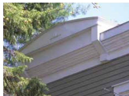
Parapet et corniche décoratifs au sommet de la façade d'une maison Boomtown
