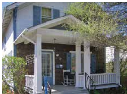
Galerie couverte dotée de piliers et d'un garde-corps ouvragé en bois et ornée d'un fronton
