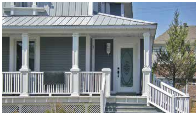
La galerie couverte de cette maison à mansarde participe à l'intérêt patrimonial du bâtiment.
