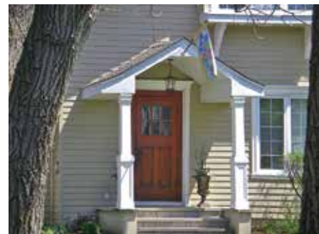
Simple porche en bois devant une entrée avec piliers ouvragés
