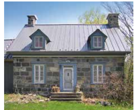
Maison franco-québécoise avec murs en pierre et toiture en tôle
