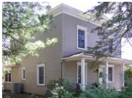
Maison Boomtown recouverte d'un matériau léger imitant le bois
