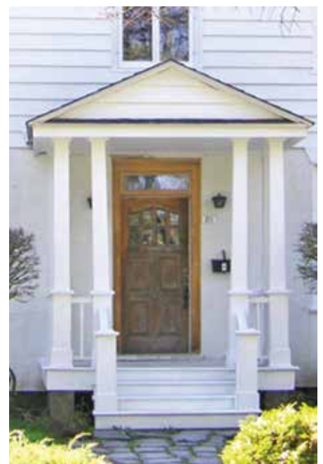
Porche aménagé devant une entrée principale
