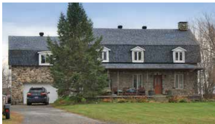
Le garage ajouté à gauche de cette maison à mansarde respecte les bons principes d'agrandissement.
